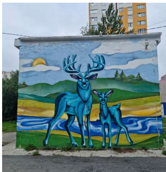
ТП в Тобольске, 10 мкр.
